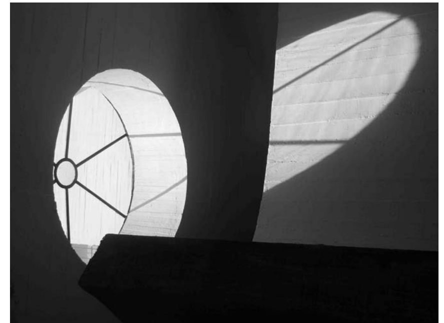
Detalle de lucernario, Capilla del Monasterio Benedictino (1964), Santiago, Chile Arquitectos: Gabriel Guarda, Martín Correa Fotografía: Carlos Jiménez, Febrero 2013
