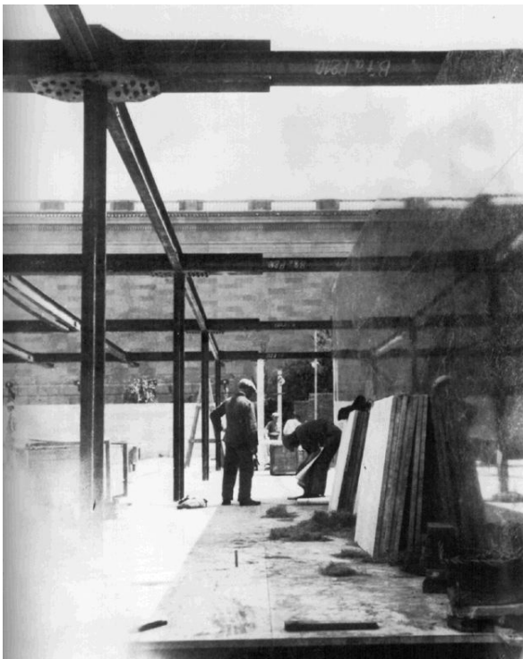
El Pabellón de Barcelona en construcción, fotografía del año 1929
